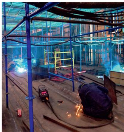
ной арматуры, а также выполнен монтаж гребных валов, лопастей ВРШ и рулевого устройства. Началась погрузка и предварительный монтаж труб газохода. Ведётся монтаж трубопроводов систем: балластной, осушительной, воздушно-измерительной, водяного пожаротушения, систем вентиляции, систем охлаждения ГД, топливных систем.
