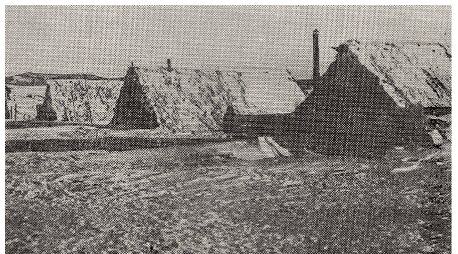
Первые жилища первостроителей города
